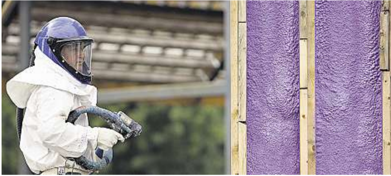
La maison Pure Énergie de la famille Chevalier-Brault, en construction à Saint-Basile-le-Grand, a été enrobée d'une combinaison de mousses isolantes de polyuréthane, à l'intérieur et à l'extérieur.
